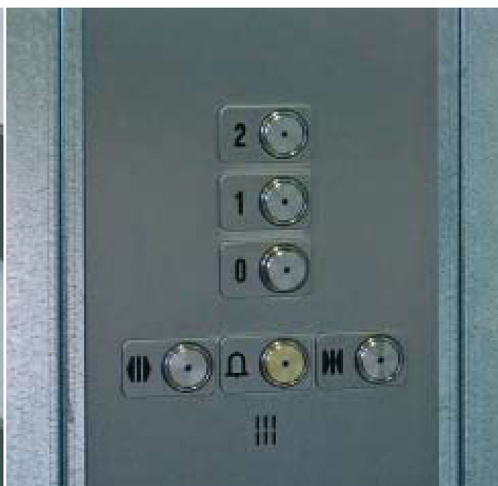
Панели управления в кабине лифта из нержавеющей стали, с защитой от умышленной порчи
