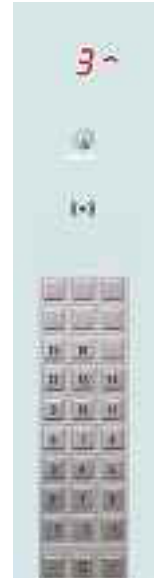
Приказной аппарат в кабине лифта, нажимные кнопки
