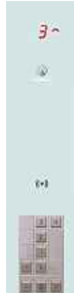
Приказной аппарат в кабине лифта, нажимные кнопки
